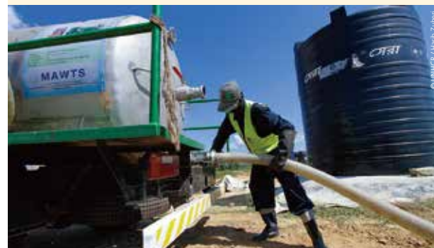
UNHCRは世界の難民キャンプで最大のし尿プラントを建設し、一日に15万人の排泄物の処理が可能に。各家庭の排泄物をプラントに送る際、ボランティアが大きな役割を果たしている
