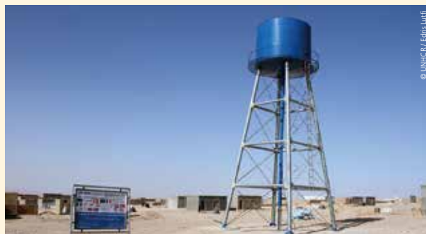
約170世帯が避難する村で、UNHCRは水の供給、道路などインフラの整備、シェルターの提供などを実施している
